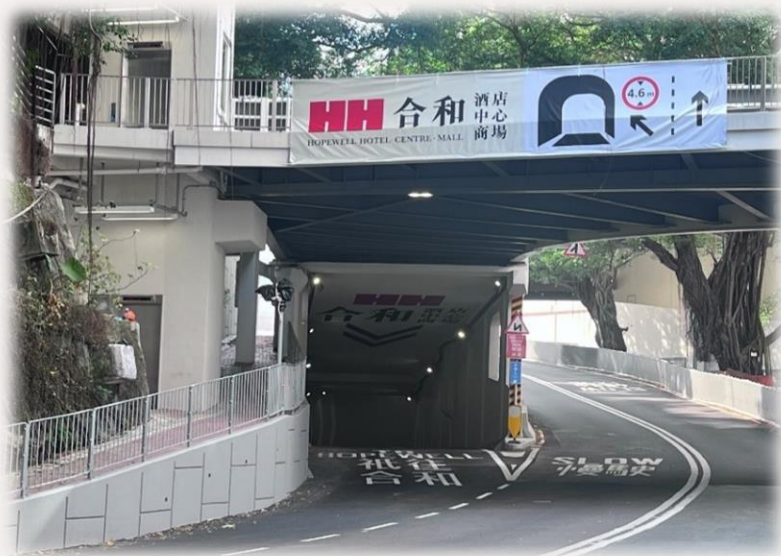
Hopewell Tunnel, 15 Kennedy Road 合和隧道，堅尼地道15號
